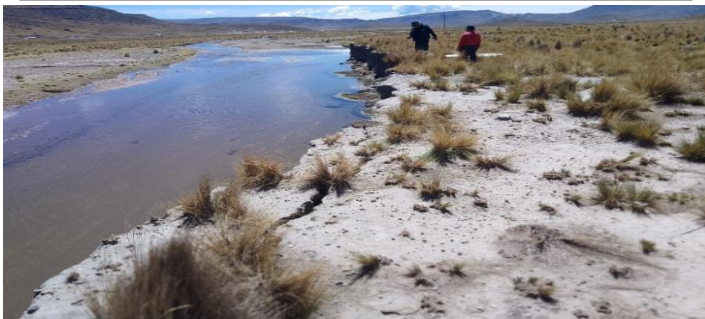
FIGURA N°02: EN LA TEMPORADA DE MAXIMAS AVENIDAS, DEL RIO MAURI CHICO A LA MARGEN DERECHA DEL CAUCE PRESENTA SOCAVACION AFECTANDO A BUZON Y PLANTA DE TRATAMIENTO
